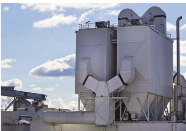
Planta de energía Kaukaan Voima, Lappeenranta, Finlandia
