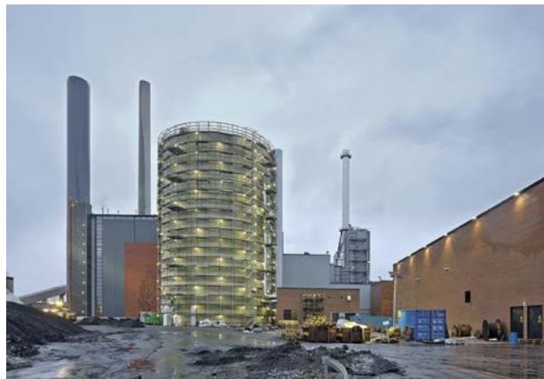
Batería térmica de calefacción distrital, Fortum, Espoo, Finlandia
