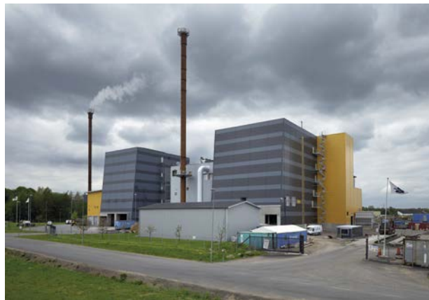
Planta de calefacción de distrito, Skövde, Suecia
