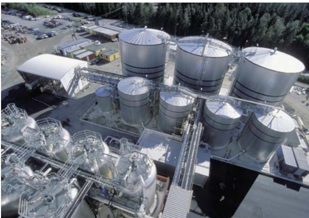
Destilería de aceite de pino, Forchem Oy, Rauma, Finlandia
